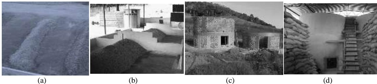
Figura 1. Vistas parciais do sistema instalado para a secagem combinada: (a) terreiro pavimentado, (b) sistema de secagem de leito fixo, em leiras, (c) construção dos silos secadores e (d) silo secador/armazenador.
