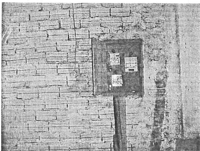
FIGURA 39 – Improvisos: painel de comando de madeira.
