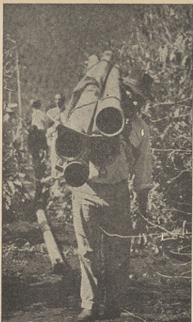
Os tubos de duralumínio são suficientemente leves para que seu transporte se faça com facilidade e sem maior esforço.
