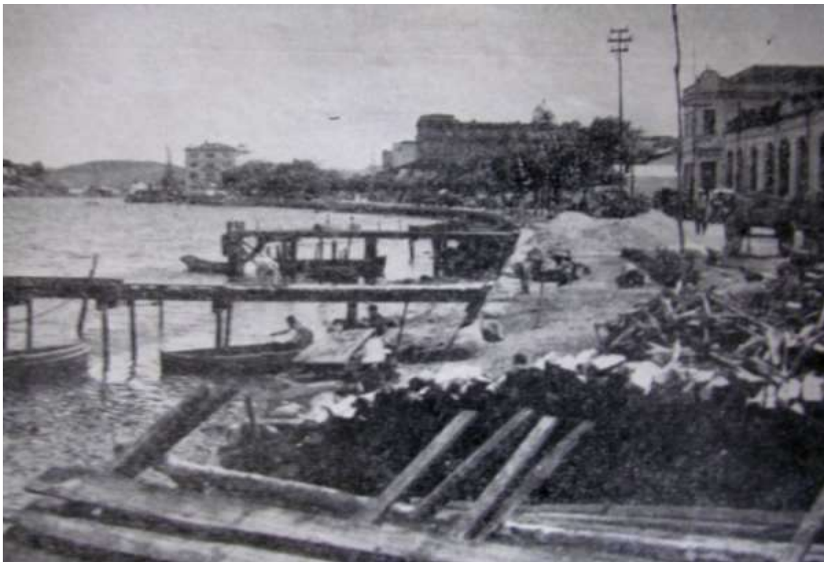
Figura 14: Enseada da Capixaba, antes das obras de aterro Fonte: O ESPÍRITO Santo trabalha e confia: 1951-1955. [S.l.:s.n.], 1958.
