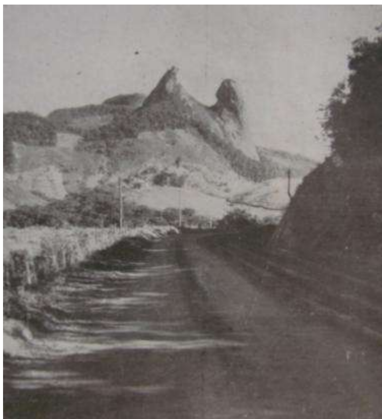
Figura 53: Trecho pavimentado na rodovia Iconha Rio Novo: ao fundo, “o Frade e a Freira” Fonte: O ESPÍRITO Santo trabalha e confia: 1951-1955. [S.l.:s.n.], 1958.
