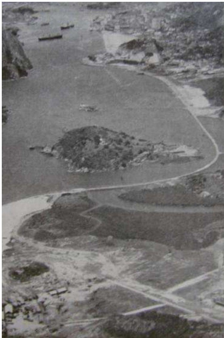
Figura 19: Vista da obra realizada entre o Forte de São João e Bento Ferreira Fonte: O ESPÍRITO Santo trabalha e confia: 1951-1955. [S.l.:s.n.], 1958.
