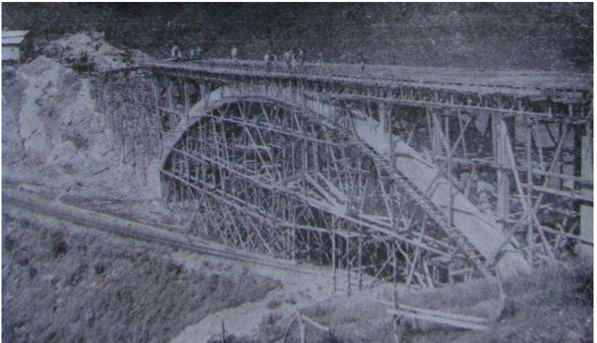
Figura 45: Rodovia Vitória - Colatina: passagem superior em João Neiva sobre a estrada de ferro Vitória - Minas Fonte: O ESPÍRITO Santo trabalha e confia: 1951-1955. [S.l.:s.n.], 1958.
