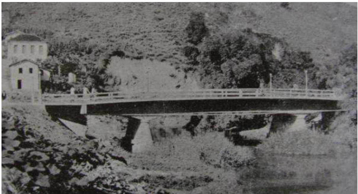
Figura 47: Ponte sobre o Rio Farinho: Santa Leopoldina – Rio Bonito Fonte: O ESPÍRITO Santo trabalha e confia: 1951-1955. [S.l.:s.n.], 1958.
