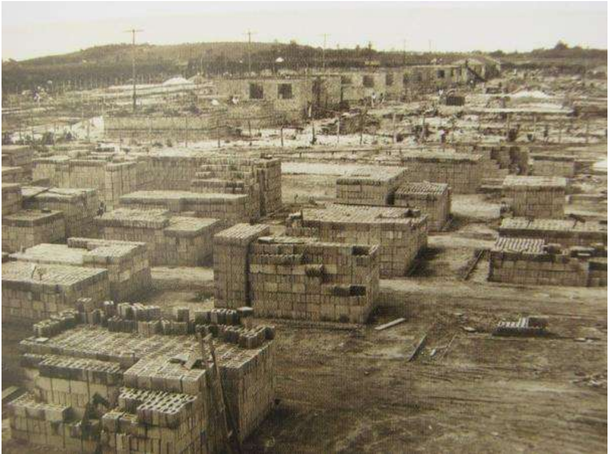
Figura 95: Casas em construção no conjunto habitacional planejado pelo IBES Fonte: O ESPÍRITO Santo trabalha e confia: 1951-1955. [S.l.:s.n.], 1958.
