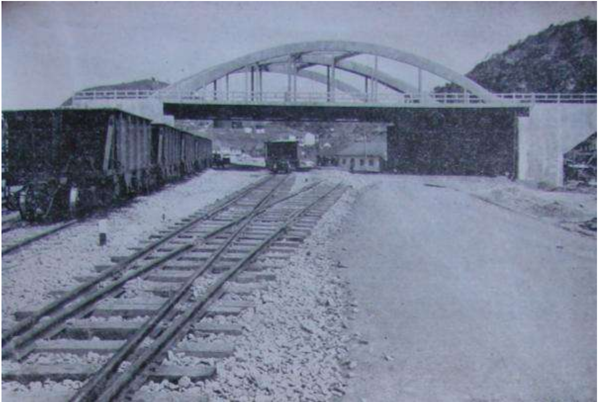
Figura 44: Viaduto de São Torquato: passagem superior sobre a estrada de ferro Vitória - Minas Fonte: O ESPÍRITO Santo trabalha e confia: 1951-1955. [S.l.:s.n.], 1958.
