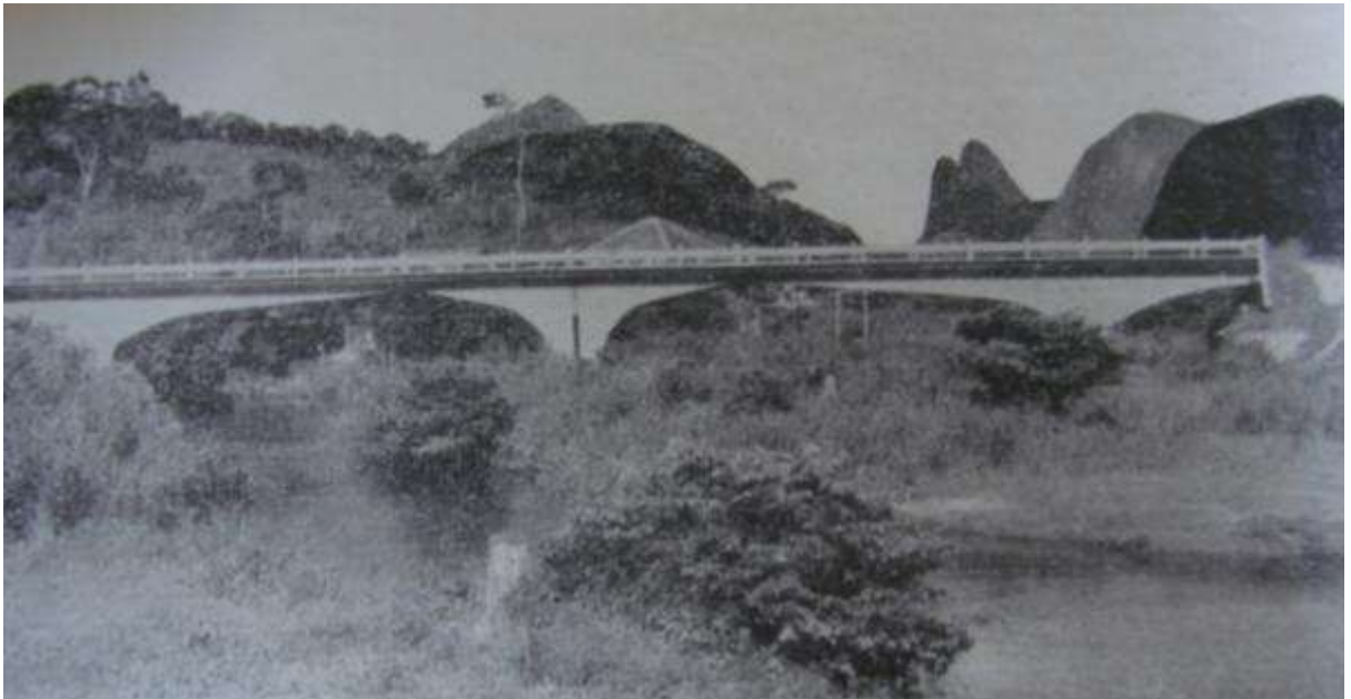
Figura 49: Ponte Águia Branca: Rodovia São Domingos – Barra de São Francisco Fonte: O ESPÍRITO Santo trabalha e confia: 1951-1955. [S.l.:s.n.], 1958.
