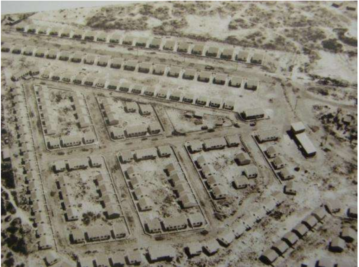
Figura 94: Vista aérea de parte do conjunto habitacional planejado pelo IBES Fonte: O ESPÍRITO Santo trabalha e confia: 1951-1955. [S.l.:s.n.], 1958.
