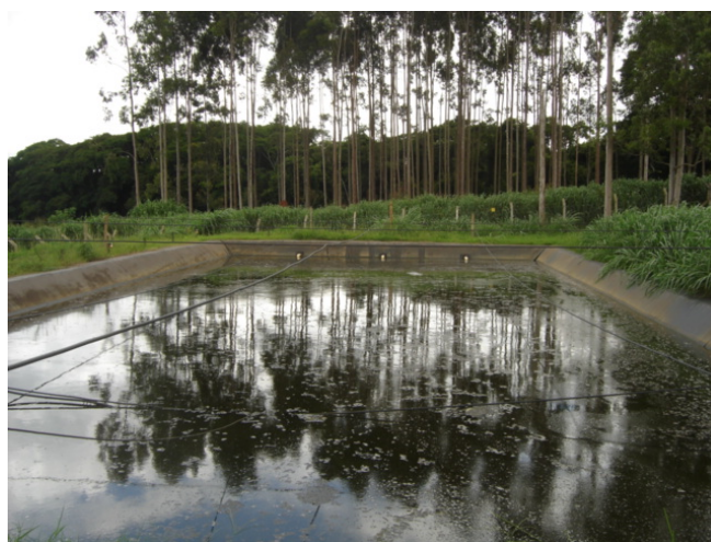
FIGURA 6. Lagoa de estabilização do sistema piloto de tratamento da água residuária do café, localizado no NECAF/UFLA.
