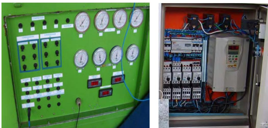
Figura 11 – Painel de controle e quadro de comando com inversor de frequência.
