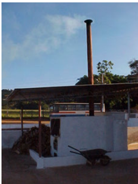
Figura 6 – Vista lateral da fornalha a fogo indireto com lenha dos terreiros secadores.
