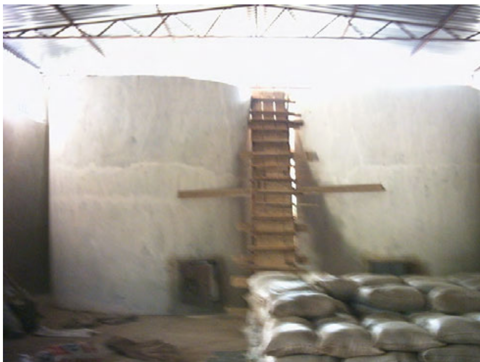
Figura 12 – Silos em concreto onde foi realizada a secagem complementar do 3 o tratamento.
