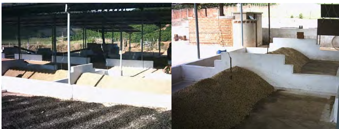
Figura 9 – Vista dos terreiros secadores sem incidência solar direta.
