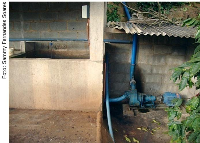
Figura 21. Bombeamento da caixa de decantação para reúso.
