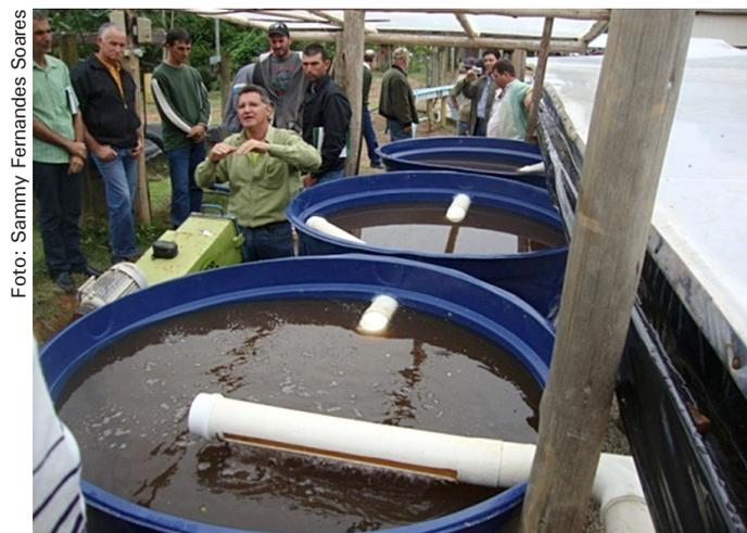
Figura 24. Caixas de decantação do Sistema de Limpeza de Águas Residuárias (SLAR).
