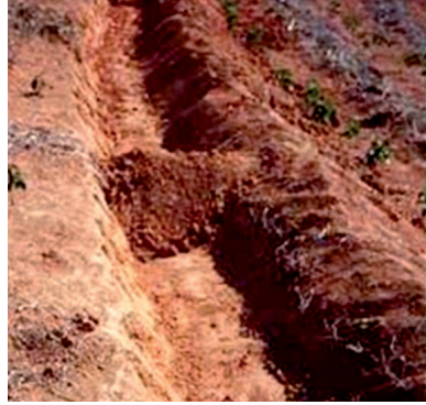
Figura 2. Terraço em nível e caixa de contenção de água (à esquerda) e travesseiro do terraço (à direita).
