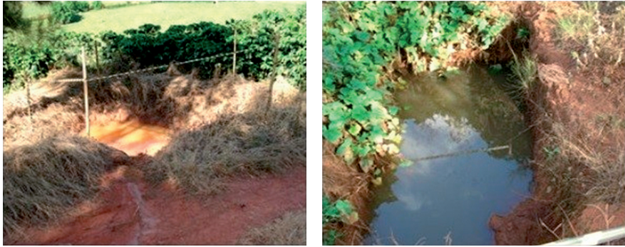
Figura 3. Caixa de contenção, ou captação de água da chuva, recebendo água do escoamento superficial misturada com a presença de partículas de solo (à esquerda) e caixa recebendo água limpa, após estabilização do solo (à direita).
