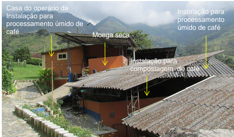
Figura 10 – Instalação para processamento úmido de café, no município de Bello, vista sul/oeste.
