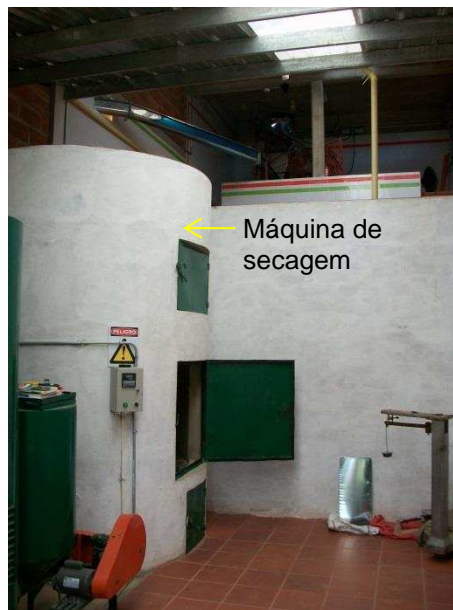
Figura 25 – Revestimentos das superfícies no nível mais baixo da instalação para processamento úmido de café, no município de San Roque – tipologia 3.
