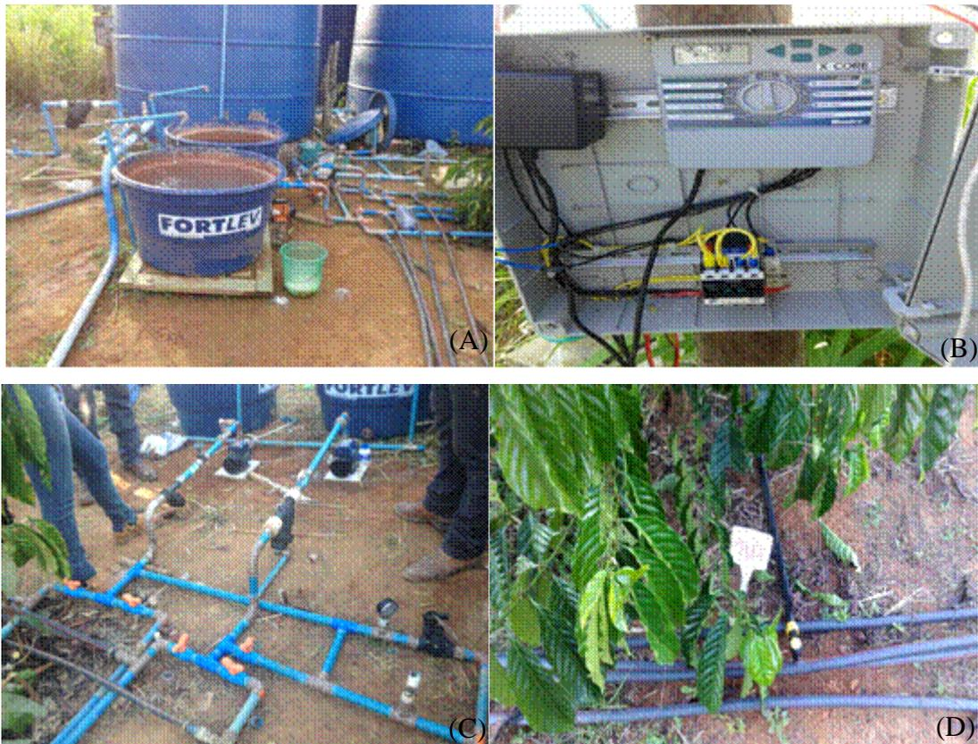
**Figura 6.** Detalhe do sistema de irrigação com as cisternas e caixas para solubilização dos adubos (A), controlador automático do sistema de irrigação (B), malha de distribuição (C) e derivação de linha (D).
