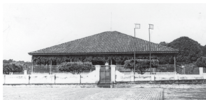
Figura 1 - Vista do muro de separação defronte a casa de morada. Fonte: Família Camargo.
