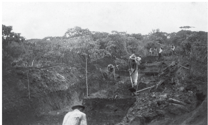
Figura 11 - Trabalhadores na construção de um canal d'água, sem data. Fonte: Acervo Família Camargo.
